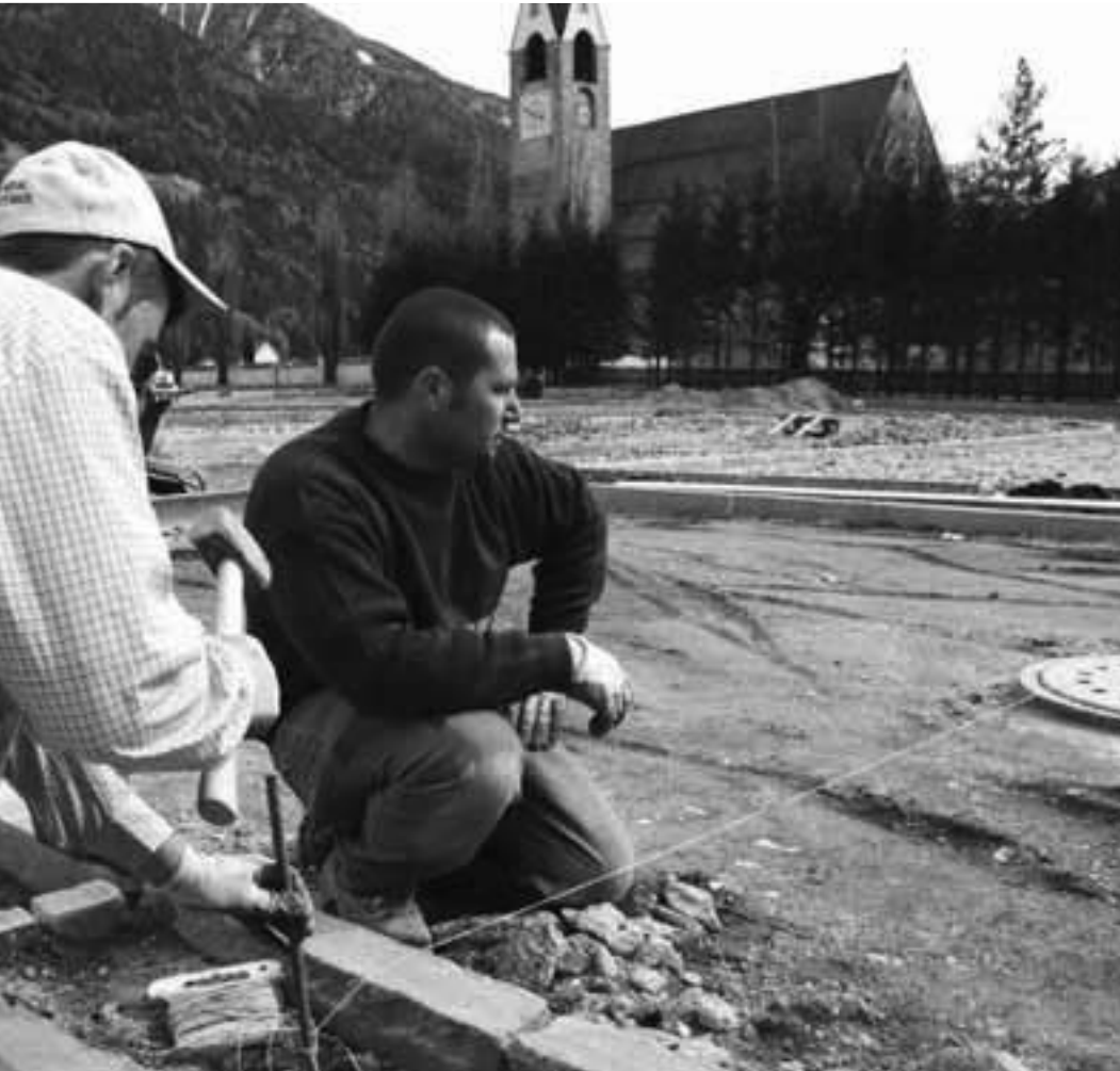
Draufgeschlagen: Baustelle Parkplatz Pfarre
