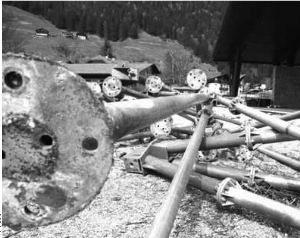
Abgerissen: Nur noch das Stahlgerippe blieb vom ehemaligen Festzelt übrig
