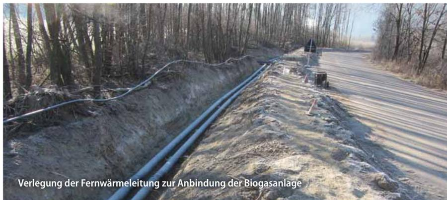
Verlegung der Fernwärmeleitung zur Anbindung der Biogasanlage
